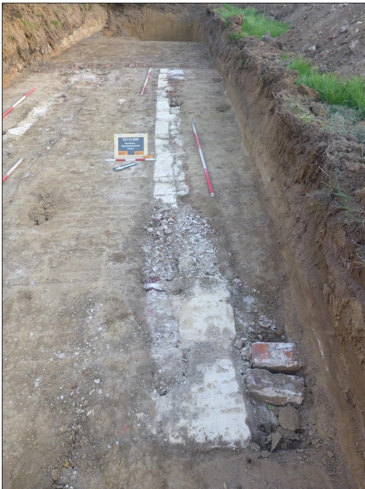
Figuur 27 Overzichtsfoto van Spoor 10 (mergel- en baksteenfundering), Werkput 2 - Vlak 1 (foto genomen naar het zuidoosten)
