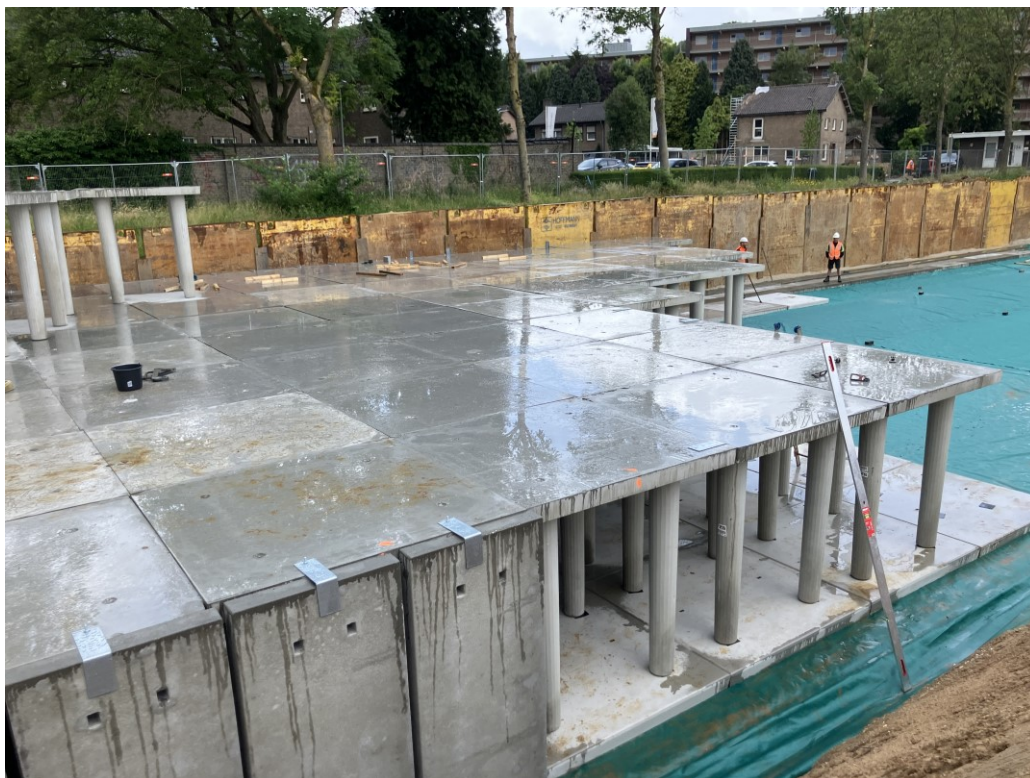
Werkzaamheden aanleg infiltratiekelder in de gemeente Beek
