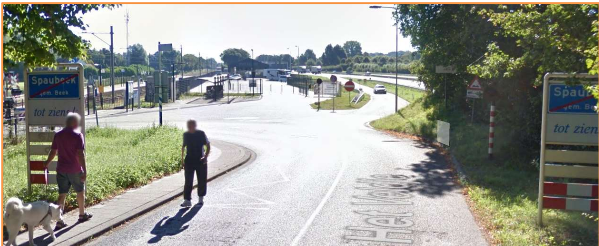
Fig. 11. De zeer vreemde en gevaarlijke noordelijke afrit van de A76, die rechtstreeks uitkomt in Op 't Veldje. De uitstulping heeft nauwelijks remmend effect. Links station Spaubeek met spoorwegovergang, waar weinig autoverkeer vandaan komt.
